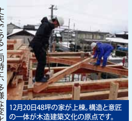
12月20日48坪の家が上棟。構造と意匠の一体が木造建築文化の原点です。
