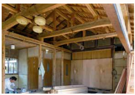
解体工事中。梁組がしっかりしているので、補強し天井高さを上げ、梁は見えるように改装。 広いダイニングキッチンだが、居間が離れているため使い勝手が悪かった。
